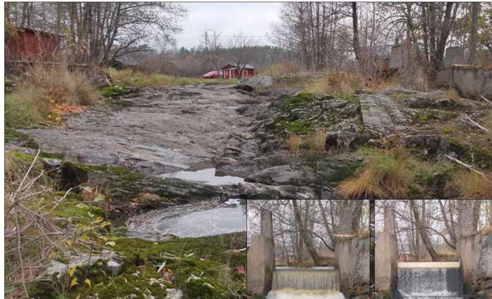
Kuvat 20-22. Pienellä virtaamalla Ilolanjoen Postimäenkoski jää kuivaksi (iso kuva) ja joen kaikki vesi virtaa patoluukun kautta muodostuen vaellusesteen. Patoon laitettiin settilankkuja, joilla vettä ohjataan luonnonkoskeen.
